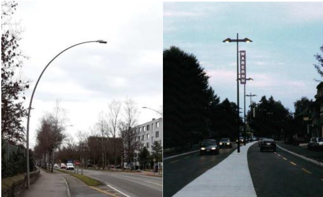
Abbildung 5.28: Bestehende Beleuchtung: Abschnitt SEFT 1 (links) und Abschnitt SEFT 2 (rechts)
